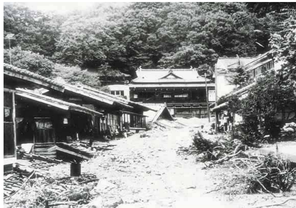
土石流で埋まった新潟県関川村の湯沢温泉地区(昭和42年羽越災害)
