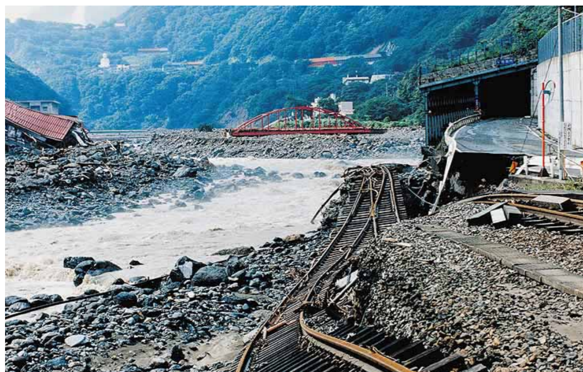
土石流にえぐりとられた国道148号とJR大系線。大網橋はそのままで土砂に埋まった。(平成7年7月災害 新潟県土木部提供)
