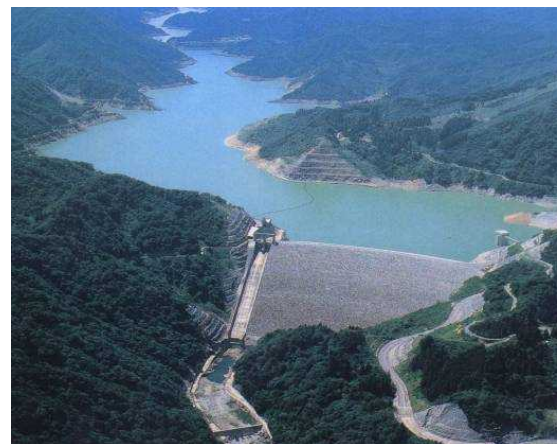
手取川ダムの外観
