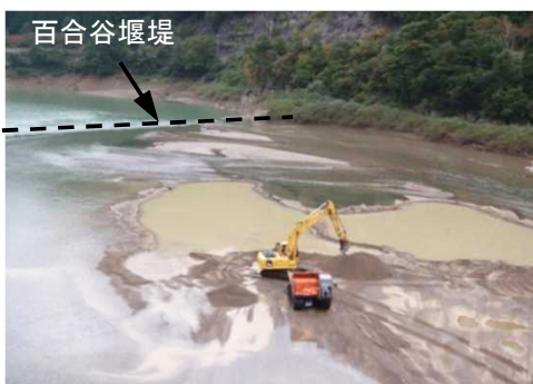
掘削積み込み状況
