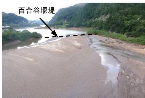
百合谷堰堤堆砂状況
