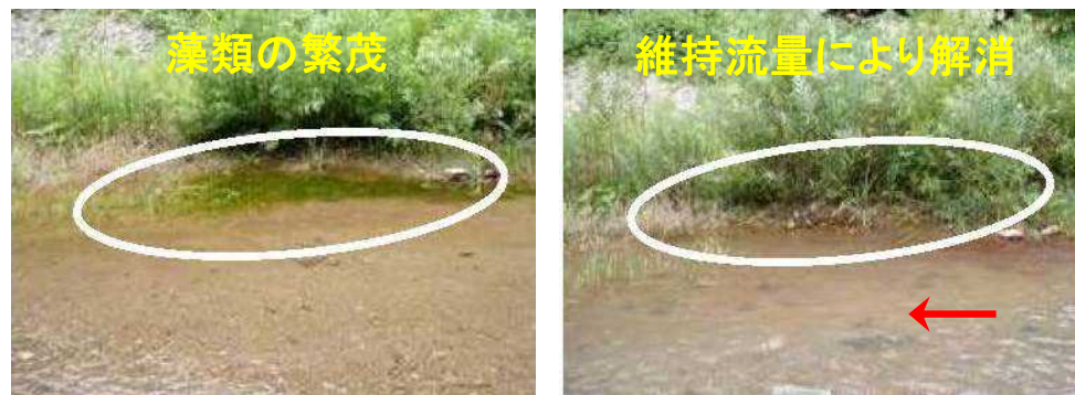
改善状況 左：放流前、右：放流後
