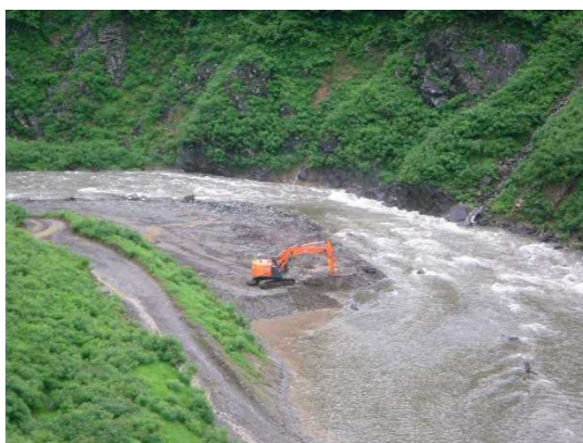
三国川ダム土砂掘削状況
