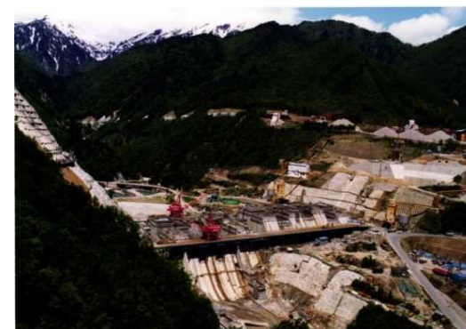
建設中の大町ダム
