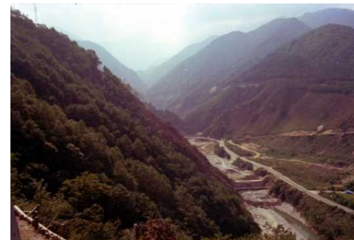
着手前の高瀬川
