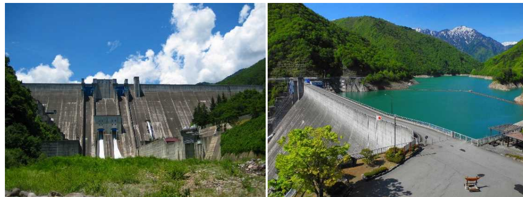
大町ダム堤体
