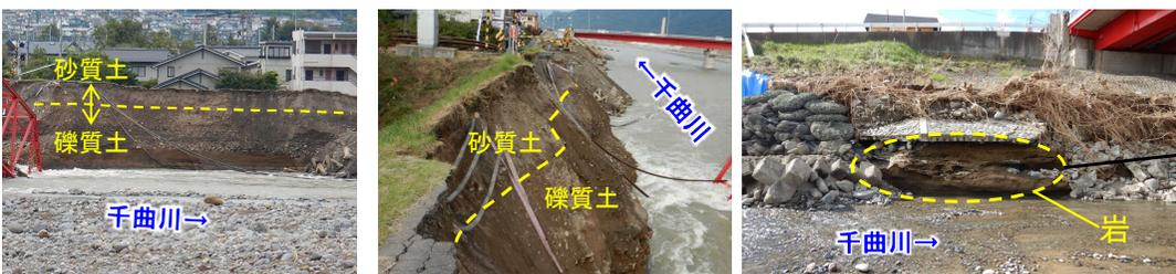
図-4 堤防欠損面及び基礎付近の土質
