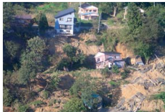
① 地すべりによる住宅崩壊、道路寸断の状況(山古志村油夫地先)
