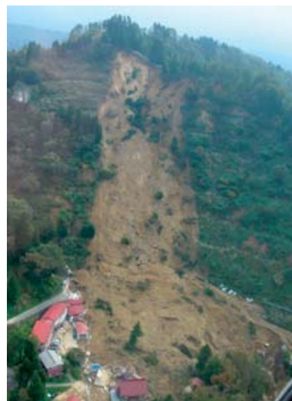
④ 人家、道路の被害状況(山古志村油夫地先)
