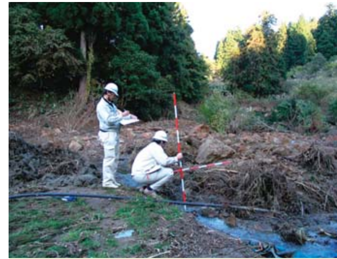
小千谷市調査状況
