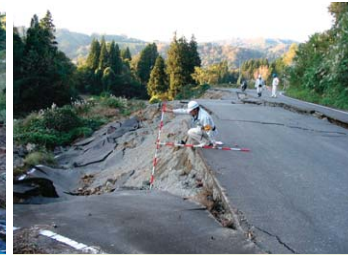
小千谷市調査状況
