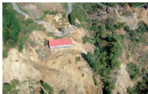
③ 人家、道路の被害状況(山古志村池谷地先)
