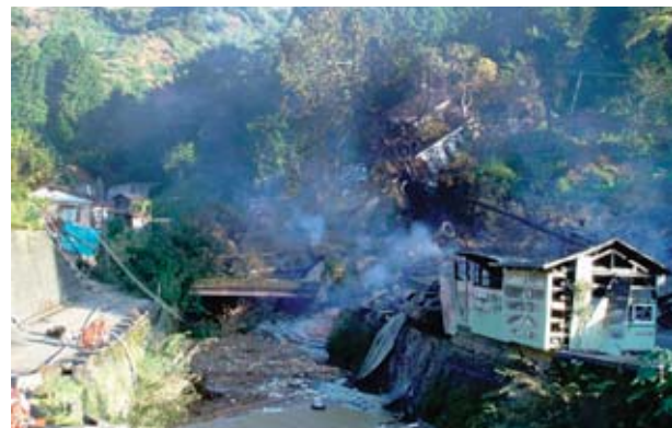
② 家屋が倒壊し、火災が発生した状況(長岡市濁沢地先)
