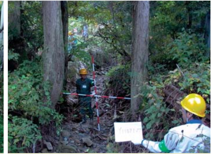
六日町調査状況
