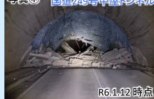
写真① 国道249号中屋トンネル
