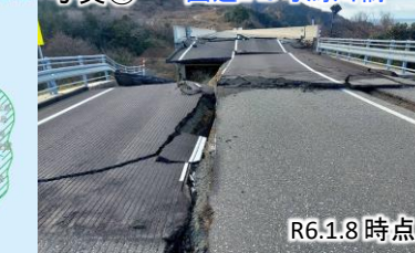
写真④ 国道249号鳥川橋
