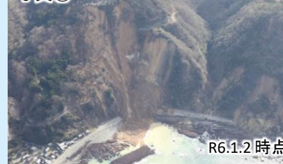
写真③ 国道249号法面崩落
