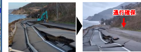
写真② 国道249号緊急復旧完了
