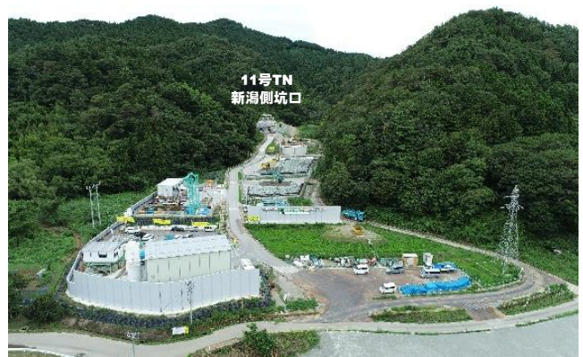
【施工ヤード全景】
