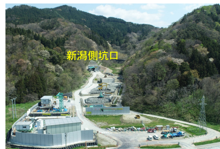
11号トンネル工事現場全景
