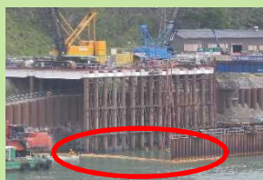
シルトフェンス (汚濁防止膜) の設置
