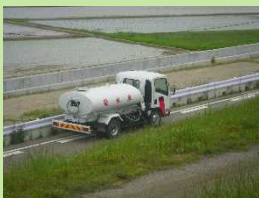
工事用道路への散水 (粉塵等抑制)
