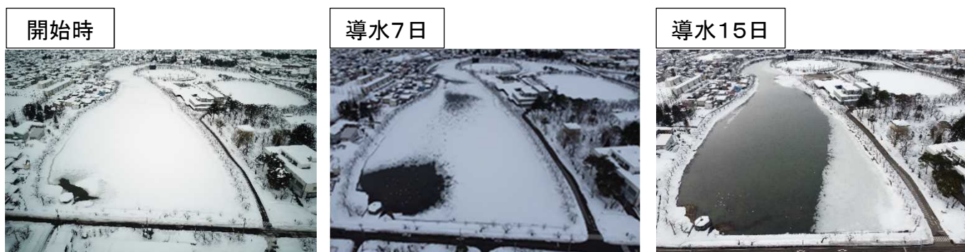
【令和3年の設備稼働状況】
