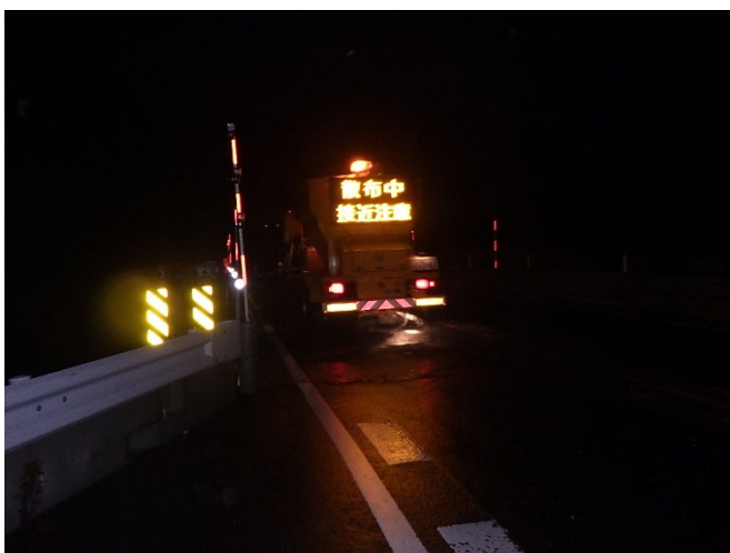
かたかけ 国道41号富山市片掛地先における作業状況
