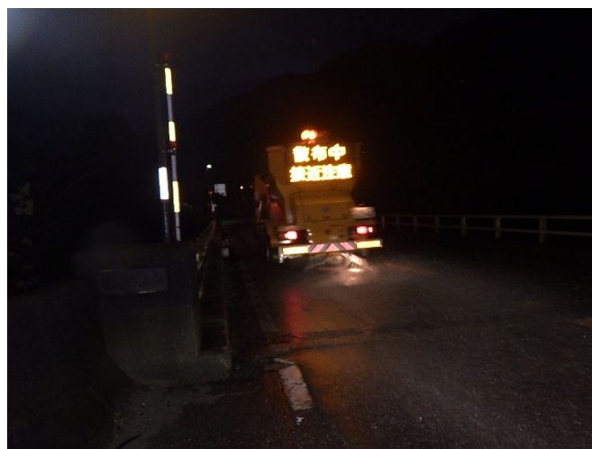
いのたに 国道41号富山市猪谷地先における作業状況
