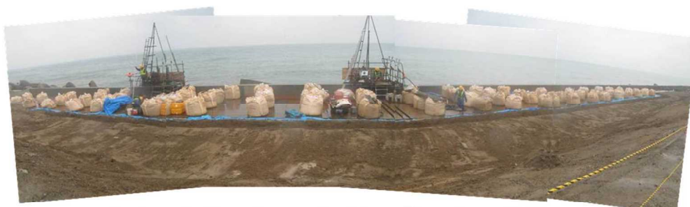
緊急復旧実施のイメージ（上記被災後の緊急復旧事例）
