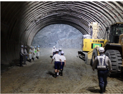
トンネル内部見学
