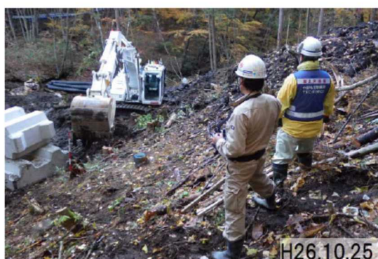
作業の安全性を考慮して、 遠隔操作無人化施工のバックホウを採用
