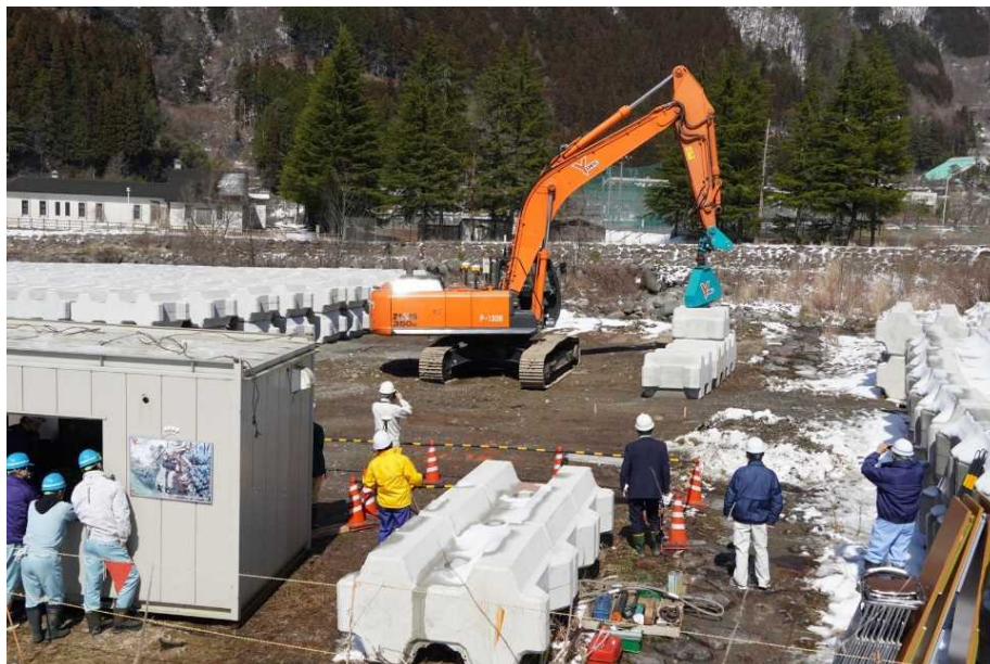
ブロック据付状況
