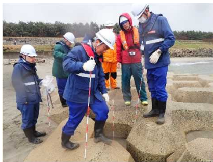
海岸の波消しブロックの点検
