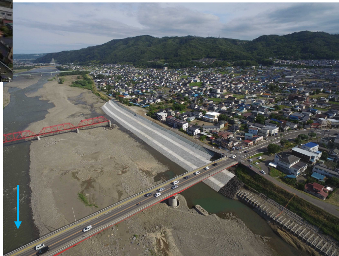
堤防及び護岸復旧完了→ (R2.6.20撮影)
