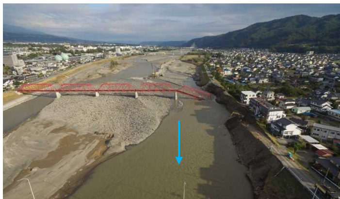
↑ 被災状況 (撮影 R元.10.14)
