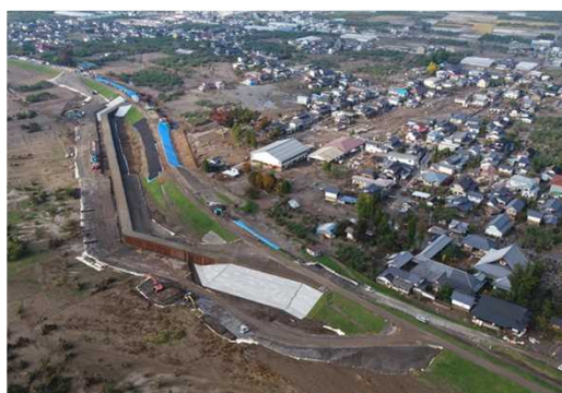
↑仮締切堤 (R元.10.30)
