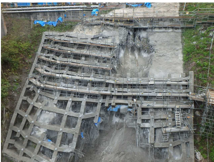
①モルタル吹付の状況 (撮影:令和2年4月24日)
