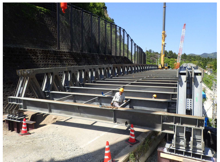
② 応急組立橋の 施工状況 (主桁・床桁)
