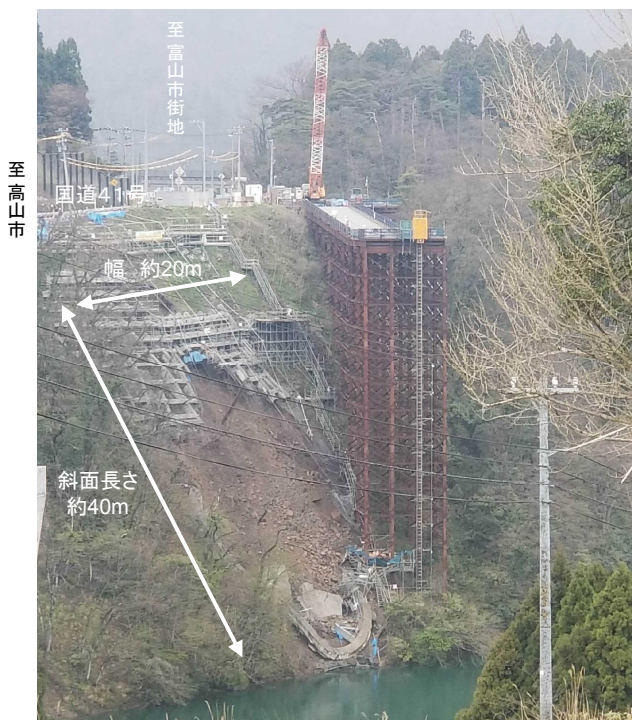
対岸より全景写真(➡撮影方向)
