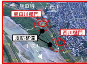
合流点処理（樋門設置・堤防整備）
