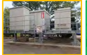
庁舎電気設備のかさ上げ（川北町）
