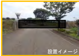
霞堤止水ゲートの設置（川北町）
