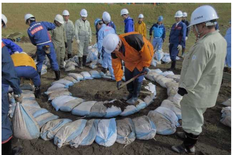
水防工法「釜段」実技 (第3回 新潟会場)
