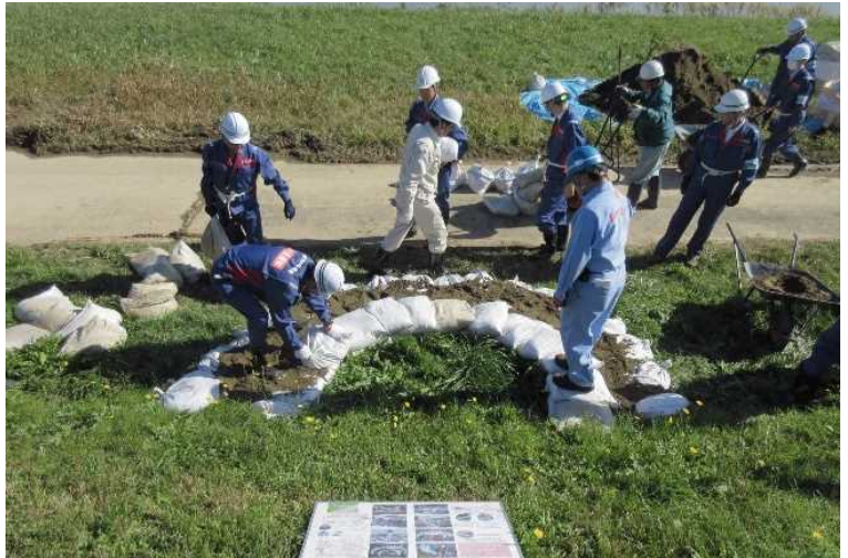
水防工法「月の輪」実技 (第3回 上越会場)
