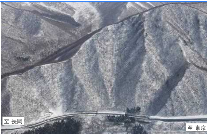
急峻な地形に位置する国道17号 冬期の状況(湯沢町三国地区)
