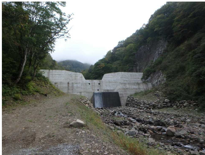
【参考】中股川第3号堰堤完成(令和2年10月撮影)
