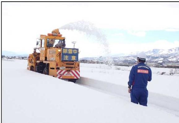
上越市大道新田地先での堤防天端除雪作業(1月20日撮影)
