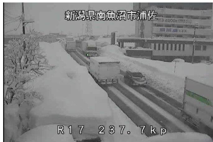
長岡方面より浦佐跨線橋を望む(15:00現在)
