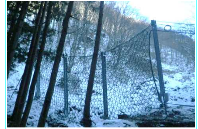
設置完了 12月2日（月）
