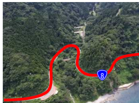
国道8号 新潟県 糸魚川市 (急カーブ区間)
