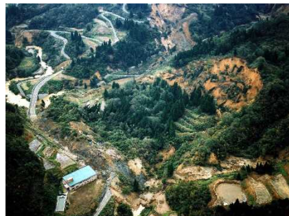
中越地震直後の東竹沢地区河道閉塞現場
