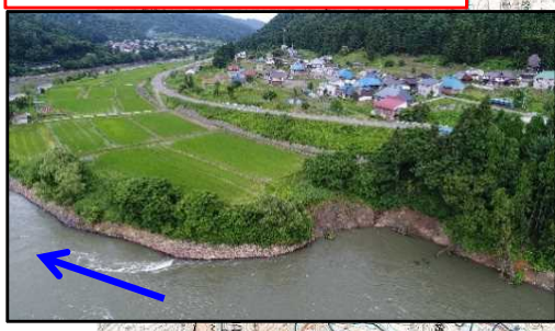
【千曲川：護岸崩壊】 長野県 野沢温泉村 七ヶ巻 地先
