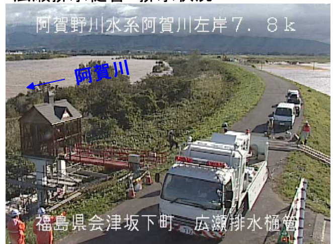
広瀬排水樋管 排水状況
