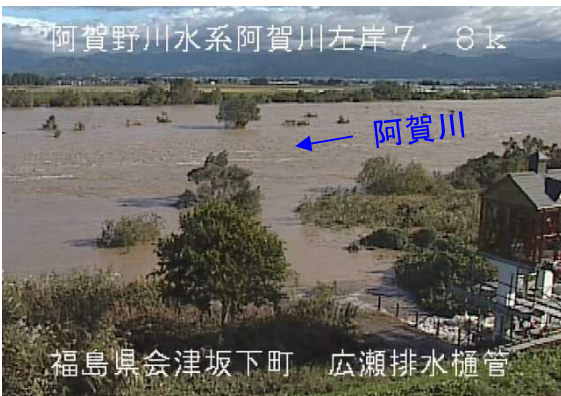
出水状況 広瀬排水樋管付近
