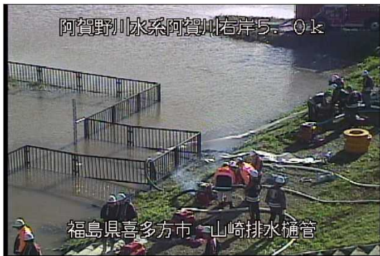
山崎地区湛水状況
