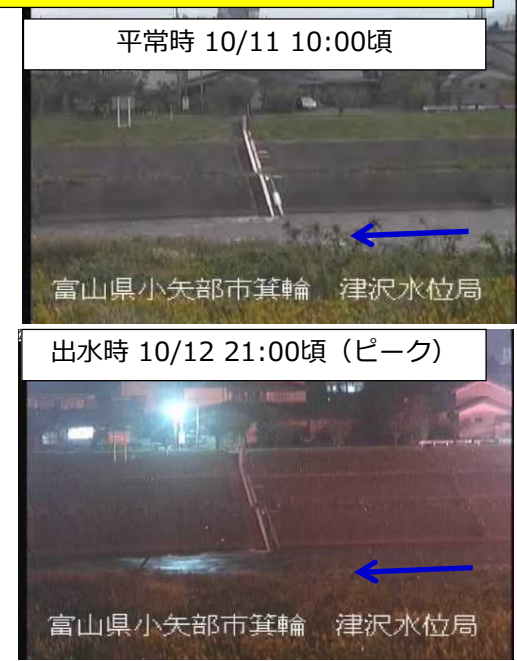
出水状況 小矢部川左岸33.0k付近
