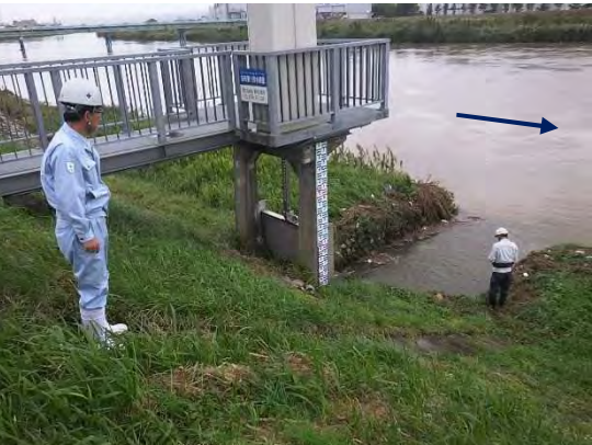
萩布第一排水樋管状況確認 (小矢部川右岸4.3k) 高岡市萩布
