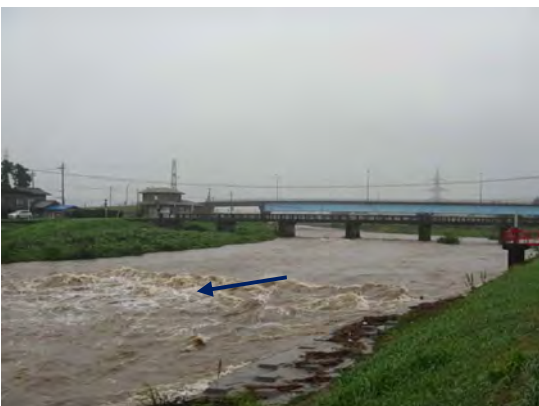
熊野川河岸状況確認 (熊野川左岸4.4k) 富山市任海
