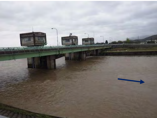
小矢部川大堰状況確認 (小矢部川35.0k) 小矢部市鴨島
