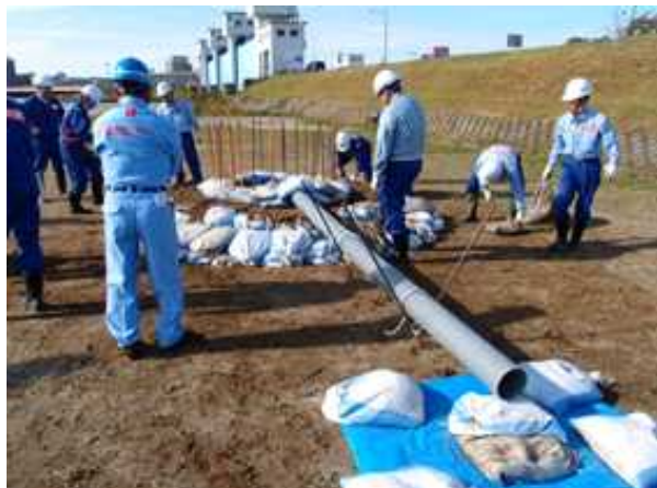
水防工法「釜段」
