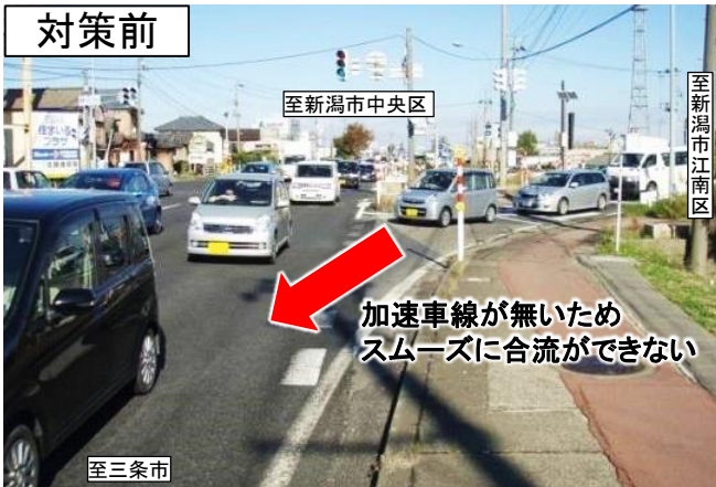
写真① 付加車線設置
