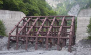
白谷第4砂防堰堤
