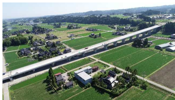
バイパス南側上空から橋全体を望む
