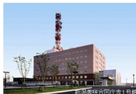
新潟美咲合同庁舎1号館（2階 港湾空港部会議室）
