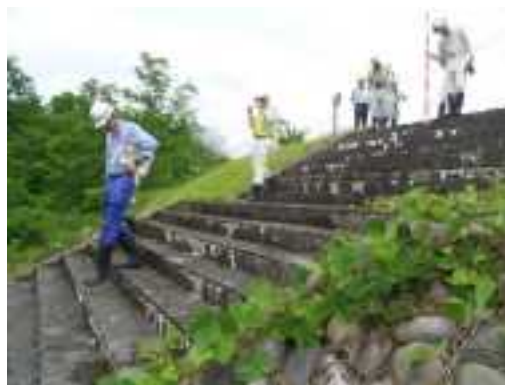
点検の状況(信濃川:新潟県)
