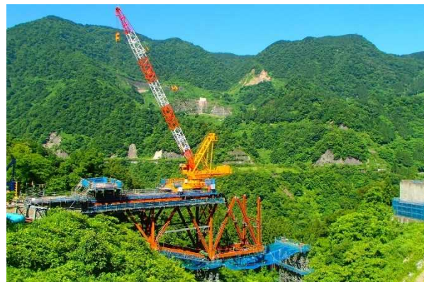
シクルビ谷の橋梁上部工事
