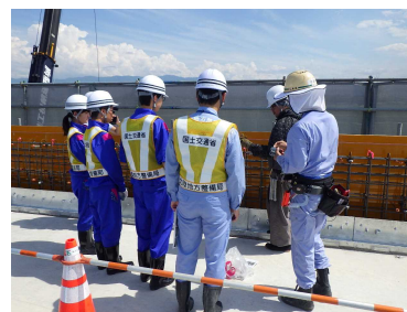
工事現場見学
