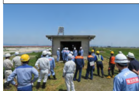
H30年度出水期前の巡視状況（庄川）
