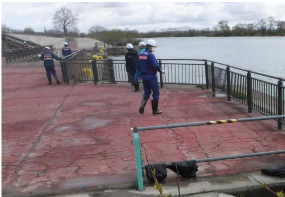
前回の点検実施状況(河川)
