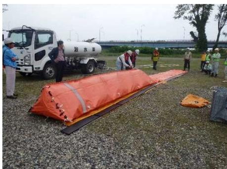
水防工法「水土のう工」
