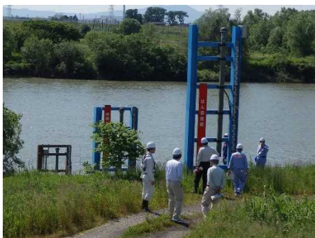
量水標の設置状況を確認 【保明新田】
