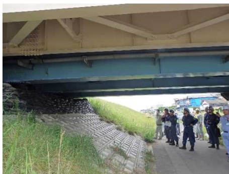
土嚢による堤防高確保の状況を確認 【信濃川大橋左岸】
