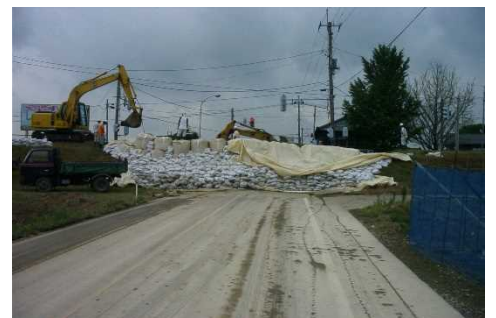
水防活動状況（H16.7 出水）
