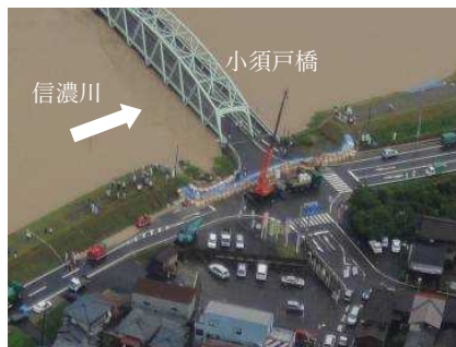
水防活動状況（H23.7 出水）
