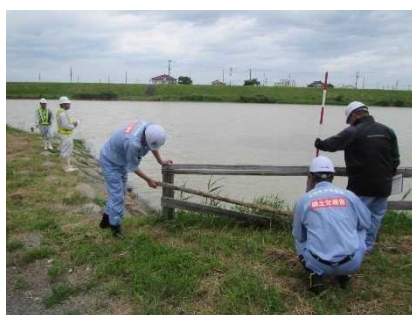
昨年の点検状況 (梯川)
