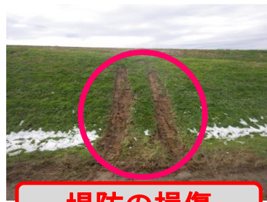
堤防の損傷
