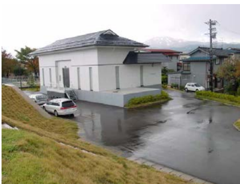
【上越消流雪用水機場】
