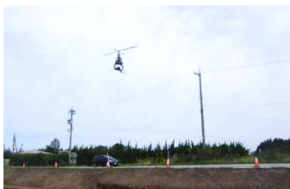
起工測量の様子
