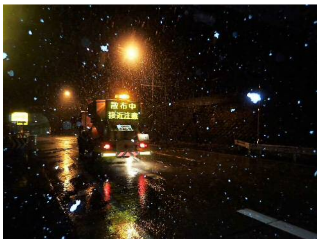
国道49号阿賀町福取地先における 凍結防止剤散布状況
